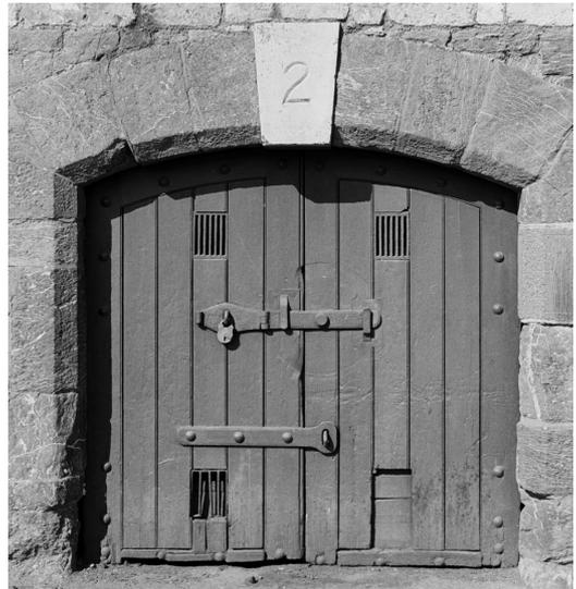
Abb. 1: Abschließmechanismen für Vermögensspeicher: Tür Nummer 2 eines Warenlagers in der Nähe des J.J. Norman Bonded Warehouse, Exe Quay, Exeter.
